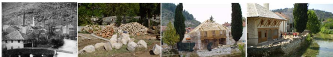
Ćuprijska džamija u Stocu: prije razaranja, nakon potpunog uništenja, tokom obnove i nakon obnove.
