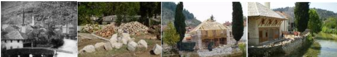
Ćuprijska džamija u Stocu: prije razaranja, nakon potpunog uništenja, tokom obnove i nakon obnove.
